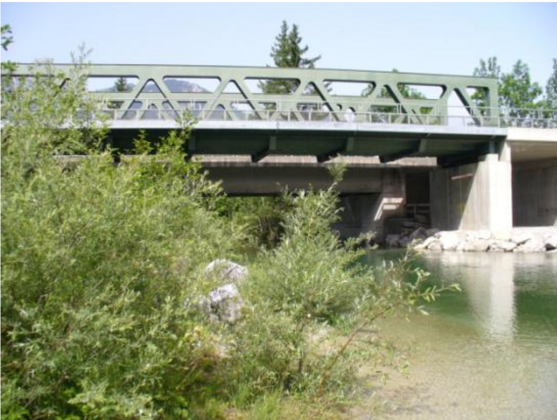
Abb. 9: Eisenbahn- und Straßenbrücke im Archbach mit Uferverbauungen; orographisch links sind die im Zuge der Hochwasserschutzmaßnahmen eingebrachten flusskrebssgerechten Strukturen zu sehen (Foto: M. Weinländer)
