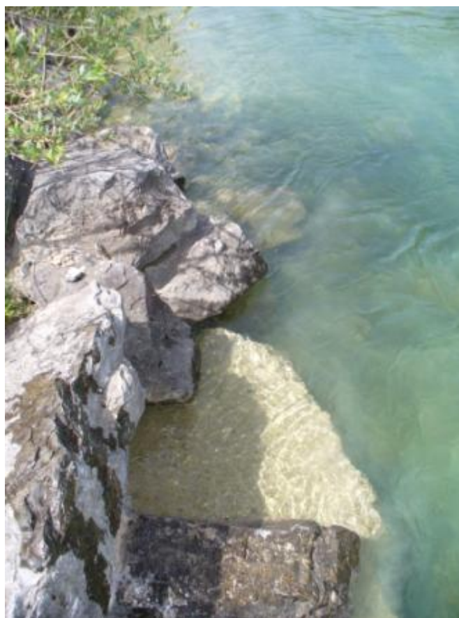
Abb. 11: Detailansicht der Uferverbauungen am Archbach (Foto: M. Weinländer)
