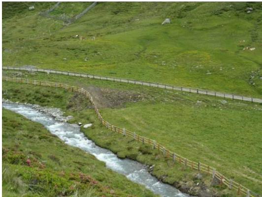
Abbildung 9 (nächste Seite): Neu errichteter Holzzaun
