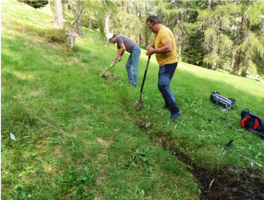
Abbildung 11: Hilfestellung von freiwilligen Mitarbeitern bei Sanierungsarbeiten an einem Entwässerungsgraben im südwestlichen Abschnitt des Erhebungsgebietes (Foto K. Auffinger 2020).
