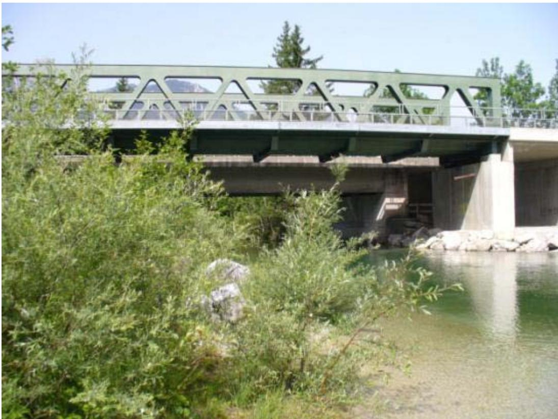
Abb. 9: Eisenbahn- und Straßenbrücke im Archbach mit Uferverbauungen; orographisch links sind die im Zuge der Hochwasserschutzmaßnahmen eingebrachten flusskrebsgerechten Strukturen zu sehen (Foto: M. Weinländer)
