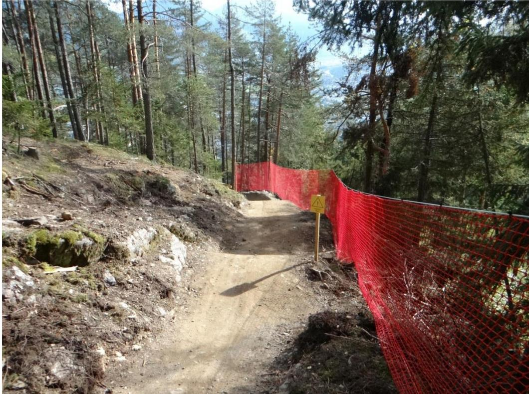
Abbildung 41: Fangnetz zur Absturzsicherung von Steilgelände
