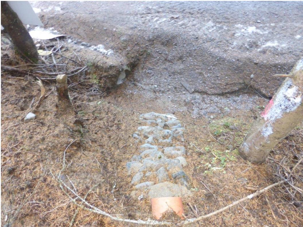
Abbildung 16: Drainageauslauf in steilem Gelände zur Verhinderung von Hangerosion.
