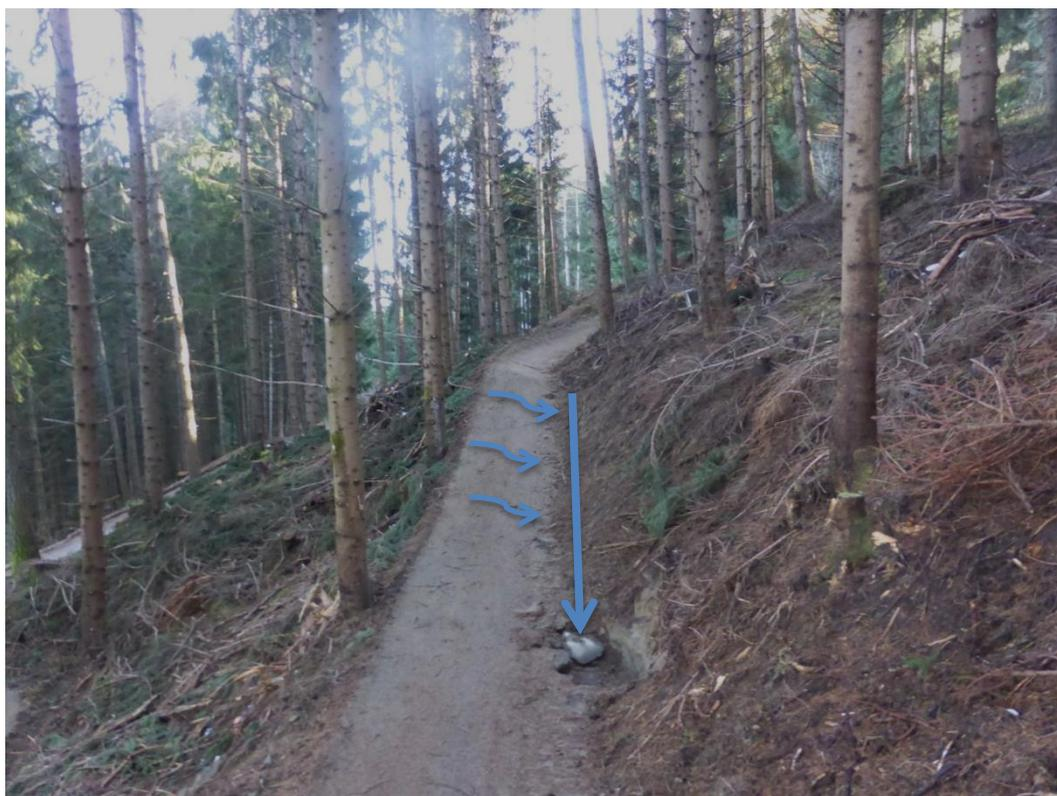
Abbildung 14: Inslope: Quergefälle zur Hangseite mit Drainageschacht. Hangseitige Ableitung des Oberflächenwassers
