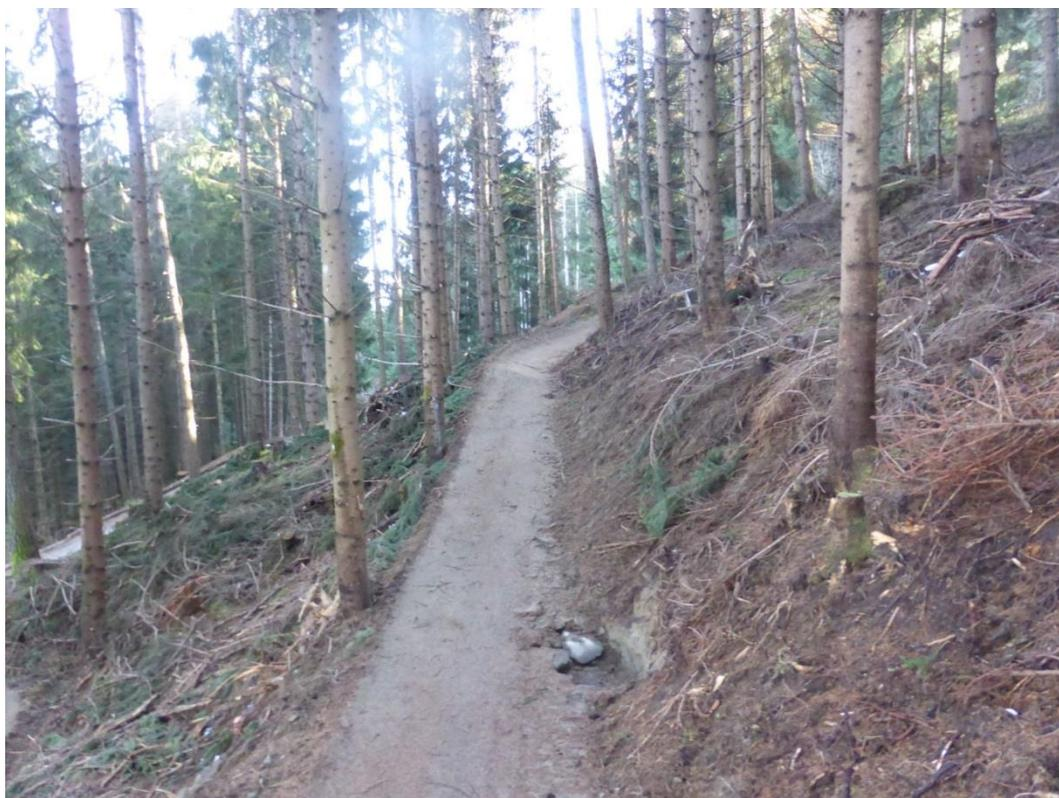
Abbildung 39: Langer flacher Kurvenauslauf, leichtes Quergefälle zur Hangseite (Inslope) gibt zusätzliche Sicherheit beim Ausfahren der Kurve.
