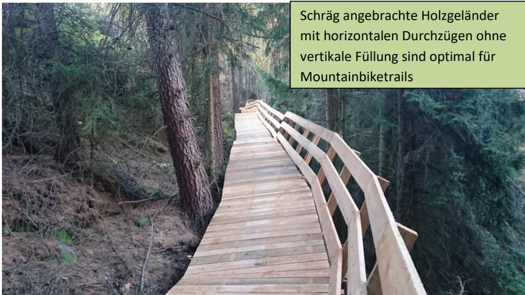
Schräg angebrachte Holzgeländer mit horizontalen Durchzügen ohne vertikale Füllung sind optimal für Mountainbiketrails
