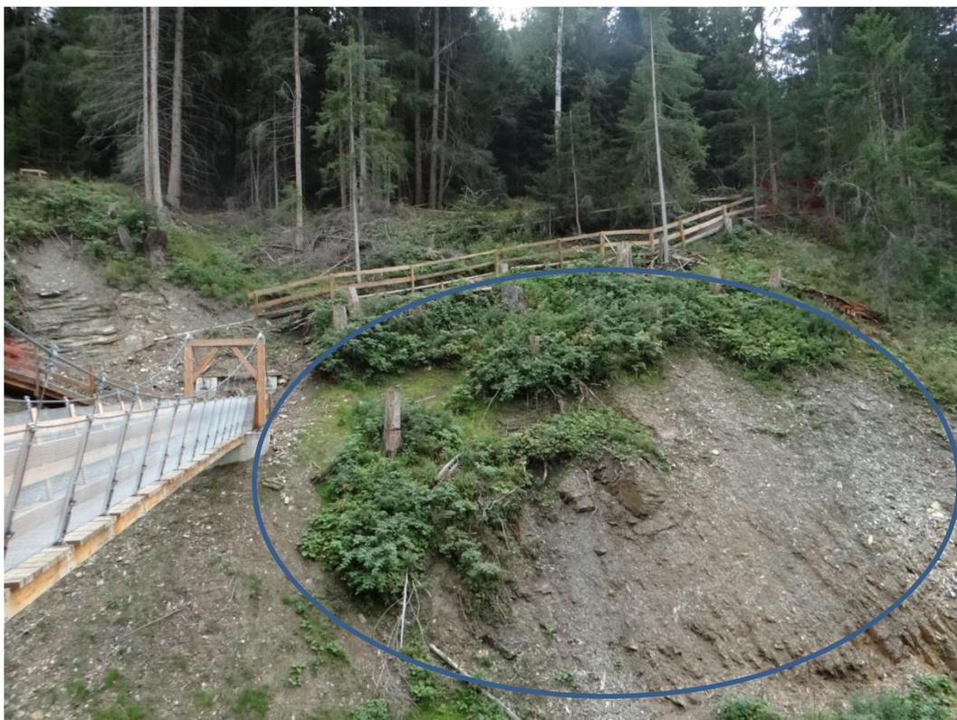
Abbildung 33: gefährliches Sturzgelände mit einer Hangneigung  $\geq 85\%$ : daher Absicherung mit Geländer
