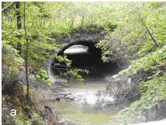
Abb. 24. Beispiele für Querbauwerke mit sonstigem Zweck. (a.: nicht passierbare Verrohrung; b.: Messwehr) (Fotos: Amt der Salzburger Landesregierung, Ref. Gewässerschutz)
