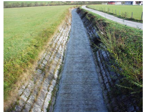
Abb. 16. Durchgehend anthropogen überformter Abschnitt, der keinerlei natürliche Strukturen mehr aufweist (Foto: Amt der Salzburger Landesregierung, Ref. Gewässerschutz)
