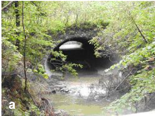
Abb. 31. a.: aufgrund zu dünner Wasserlamelle nicht passierbare Verrohrung; b.: Verrohrung mit nicht passierbarem Absturz am unteren Ende (Fotos: Amt der Salzburger Landesregierung, Ref. Gewässerschutz)
