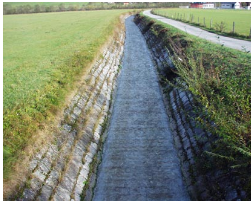
Abb. 6. Beispiele für beidseitig durchgehende Uferverbauungen, die keine Ausformung von dynamischen Uferstrukturen zulassen (Klasse 4) (Fotos: Amt der Salzburger Landesregierung, Ref. Gewässerschutz)
