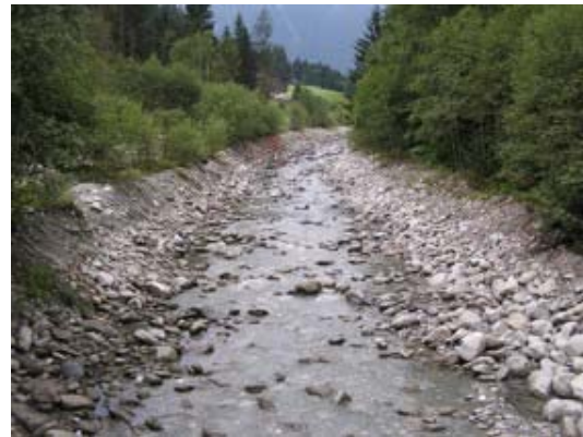
Abb. 6. Beispiele für beidseitig durchgehende Uferverbauungen, die keine Ausformung von dynamischen Uferstrukturen zulassen (Klasse 4) (Fotos: Amt der Salzburger Landesregierung, Ref. Gewässerschutz)
