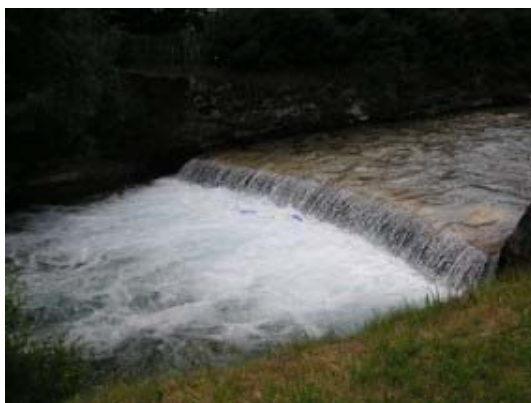
Abb. 27. Beispiele für nicht passierbare Querbauwerke mit abgelöstem Strahl (vollkommener Überfall) (Fotos: Amt der Salzburger Landesregierung, Ref. Gewässerschutz)
