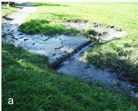
Abb. 7. Beispiele für lokale Sohlungsmaßnahmen in ansonsten unverbauten Gewässerabschnitten (Klasse 1): a.: Sohlschwelle (Querholz); b.: Sohlungsmaßnahme mit Absturz unter Brücke (Fotos: Amt der Salzburger Landesregierung, Ref. Gewässerschutz)
