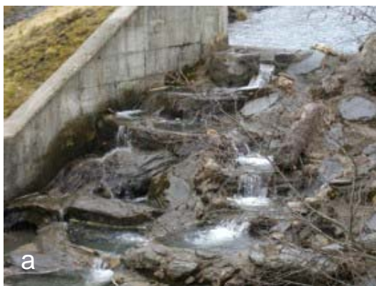
Abb. 30. a.: durch Aufspaltung des Wasserstrahls und Ausbildung von Abstürzen nicht passierbare raue Rampe; b.: aufgrund von dünner Wasserlamelle und schießendem Abfluss nicht passierbare glatte Rampe (Fotos: Amt der Salzburger Landesregierung, Ref. Gewässerschutz)
