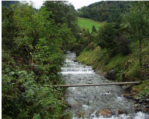
Abb. 8. Abschnitte mit lokalen Sohlsicherungsmaßnahmen und offenem Substrat zwischen den Bauwerken (Klasse 2) (Foto: Amt der Salzburger Landesregierung, Ref. Gewässerschutz)
