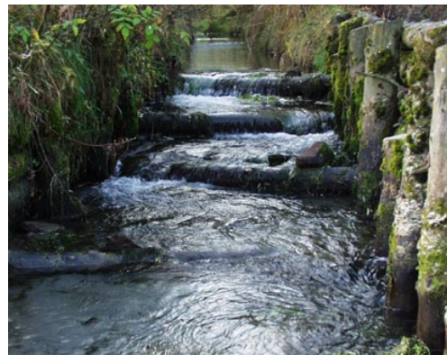
Abb. 4. Lokale Sicherungsmaßnahme in ansonsten unbeeinträchtigtem Abschnitt (Foto: Amt der Salzburger Landesregierung, Ref. Gewässerschutz)
