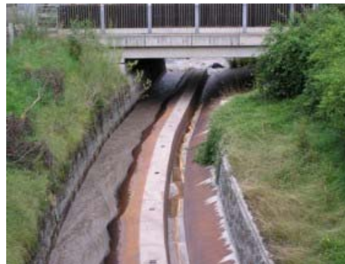
Abb. 10. Abschnitte mit vollständiger Sohlumgestaltung (Klasse 4) (Fotos: Amt der Salzburger Landesregierung, Ref. Gewässerschutz)
