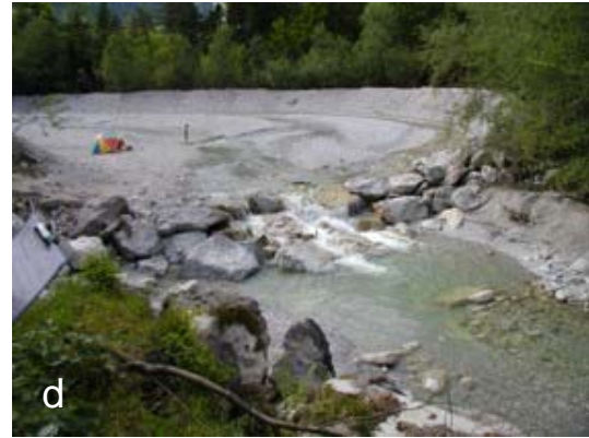
Abb. 23. Verschiedene Typen von schutzwasserbaulichen Querbauwerken (a.: Absturzbauwerk, b.: Sohlgurt, c.: Geschiebesperre, d.: raue Rampe) (Fotos: Amt der Salzburger Landesregierung, Ref. Gewässerschutz)
