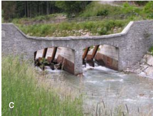
Abb. 23. Verschiedene Typen von schutzwasserbaulichen Querbauwerken (a.: Absturzbauwerk, b.: Sohlgurt, c.: Geschiebesperre, d.: raue Rampe) (Fotos: Amt der Salzburger Landesregierung, Ref. Gewässerschutz)
