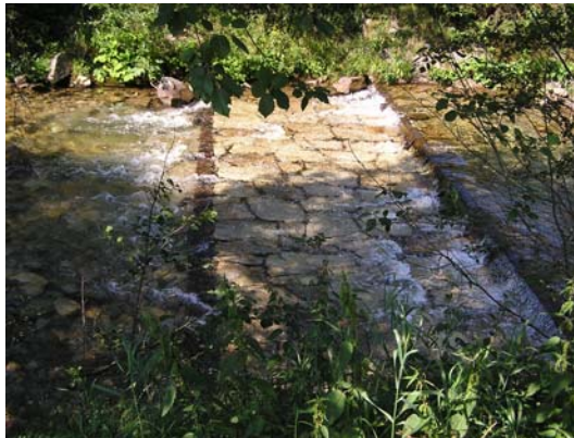
Abb. 29. Aufgrund geringer Wassertiefe nicht passierbare Sohlverbauungen (Foto: Amt der Salzburger Landesregierung, Ref. Gewässerschutz)
