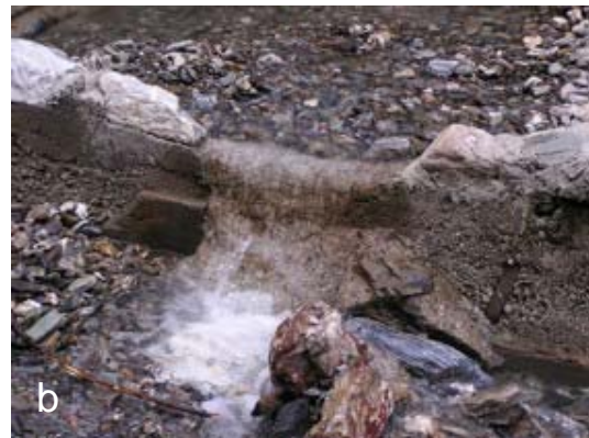
Abb. 28. a.: für Rhithralfische gerade noch durchschwimmbares Absturzbauwerk mit anliegendem Wasserpolster; b.: aufgrund dünner Wasserlamelle nicht durchschwimmbarer Wasserpolster (Fotos: Amt der Salzburger Landesregierung, Ref. Gewässerschutz)
