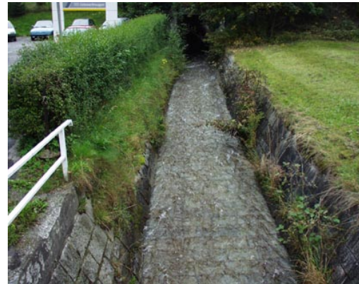
Abb. 29. Aufgrund geringer Wassertiefe nicht passierbare Sohlverbauungen (Foto: Amt der Salzburger Landesregierung, Ref. Gewässerschutz)
