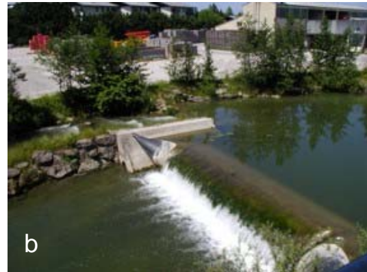
Abb. 24. Beispiele für Querbauwerke mit sonstigem Zweck. (a.: nicht passierbare Verrohrung; b.: Messwehr) (Fotos: Amt der Salzburger Landesregierung, Ref. Gewässerschutz)
