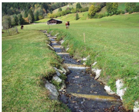
Abb. 9. Abschnitte mit durchgehenden Schwellenketten und Substrat zwischen den Bauwerken (Klasse 3) (Fotos: Amt der Salzburger Landesregierung, Ref. Gewässerschutz)
