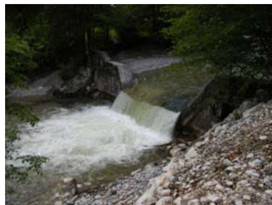
Abb. 27. Beispiele für nicht passierbare Querbauwerke mit abgelöstem Strahl (vollkommener Überfall) (Fotos: Amt der Salzburger Landesregierung, Ref. Gewässerschutz)
