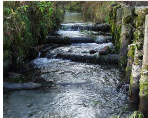
Abb. 8. Abschnitte mit lokalen Sohlsicherungsmaßnahmen und offenem Substrat zwischen den Bauwerken (Klasse 2) (Foto: Amt der Salzburger Landesregierung, Ref. Gewässerschutz)
