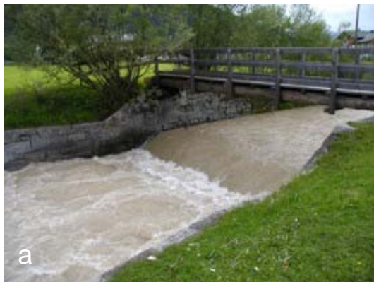
Abb. 28. a.: für Rhithralfische gerade noch durchschwimmbares Absturzbauwerk mit anliegendem Wasserpolster; b.: aufgrund dünner Wasserlamelle nicht durchschwimmbarer Wasserpolster (Fotos: Amt der Salzburger Landesregierung, Ref. Gewässerschutz)
