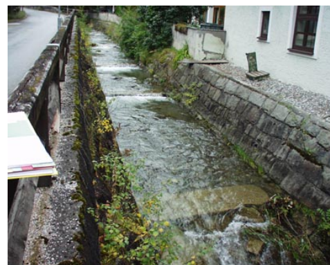
Abb. 9. Abschnitte mit durchgehenden Schwellenketten und Substrat zwischen den Bauwerken (Klasse 3) (Fotos: Amt der Salzburger Landesregierung, Ref. Gewässerschutz)
