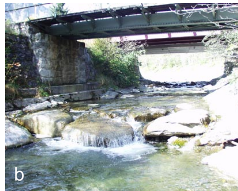
Abb. 7. Beispiele für lokale Sohlungsmaßnahmen in ansonsten unverbauten Gewässerabschnitten (Klasse 1): a.: Sohlschwelle (Querholz); b.: Sohlungsmaßnahme mit Absturz unter Brücke (Fotos: Amt der Salzburger Landesregierung, Ref. Gewässerschutz)
