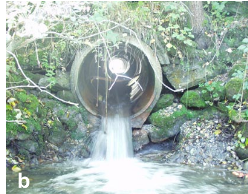
Abb. 31. a.: aufgrund zu dünner Wasserlamelle nicht passierbare Verrohrung; b.: Verrohrung mit nicht passierbarem Absturz am unteren Ende (Fotos: Amt der Salzburger Landesregierung, Ref. Gewässerschutz)
