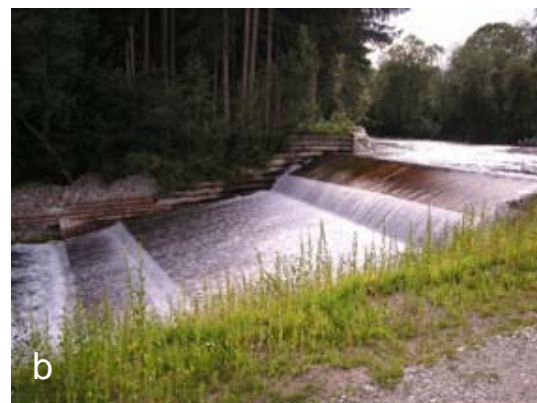
Abb. 30. a.: durch Aufspaltung des Wasserstrahls und Ausbildung von Abstürzen nicht passierbare raue Rampe; b.: aufgrund von dünner Wasserlamelle und schießendem Abfluss nicht passierbare glatte Rampe (Fotos: Amt der Salzburger Landesregierung, Ref. Gewässerschutz)
