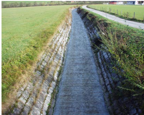
Abb. 10. Abschnitte mit vollständiger Sohlumgestaltung (Klasse 4) (Fotos: Amt der Salzburger Landesregierung, Ref. Gewässerschutz)
