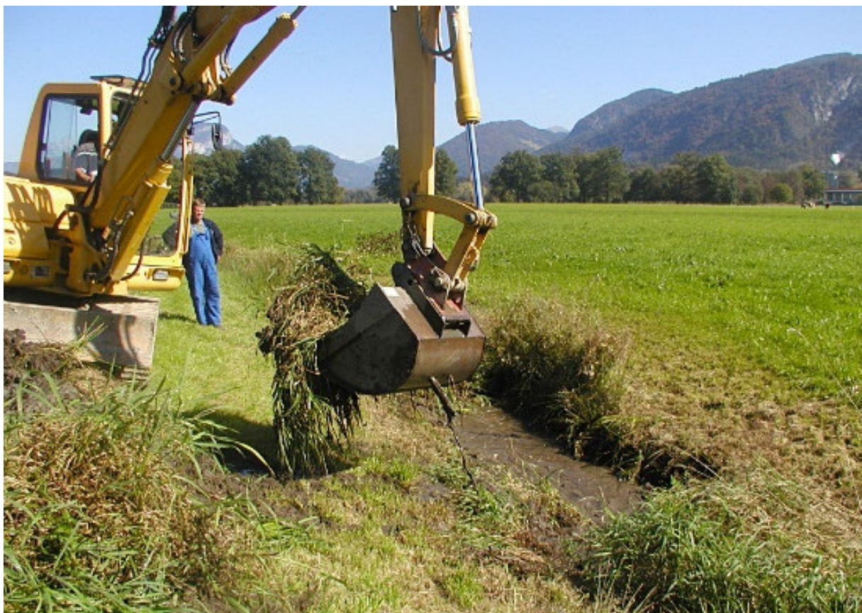
Abb. 7: Entkräutung mittels Löffelbagger
