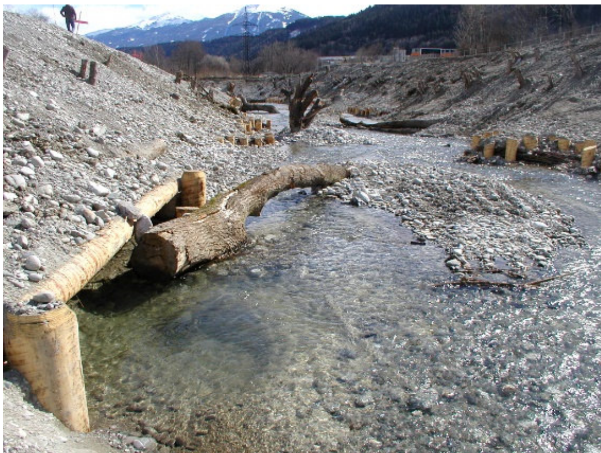
Abb. 10: Strukturierung des Ufers und des Bachbettes mittels Holzpiloten und Wurzelstöcken
