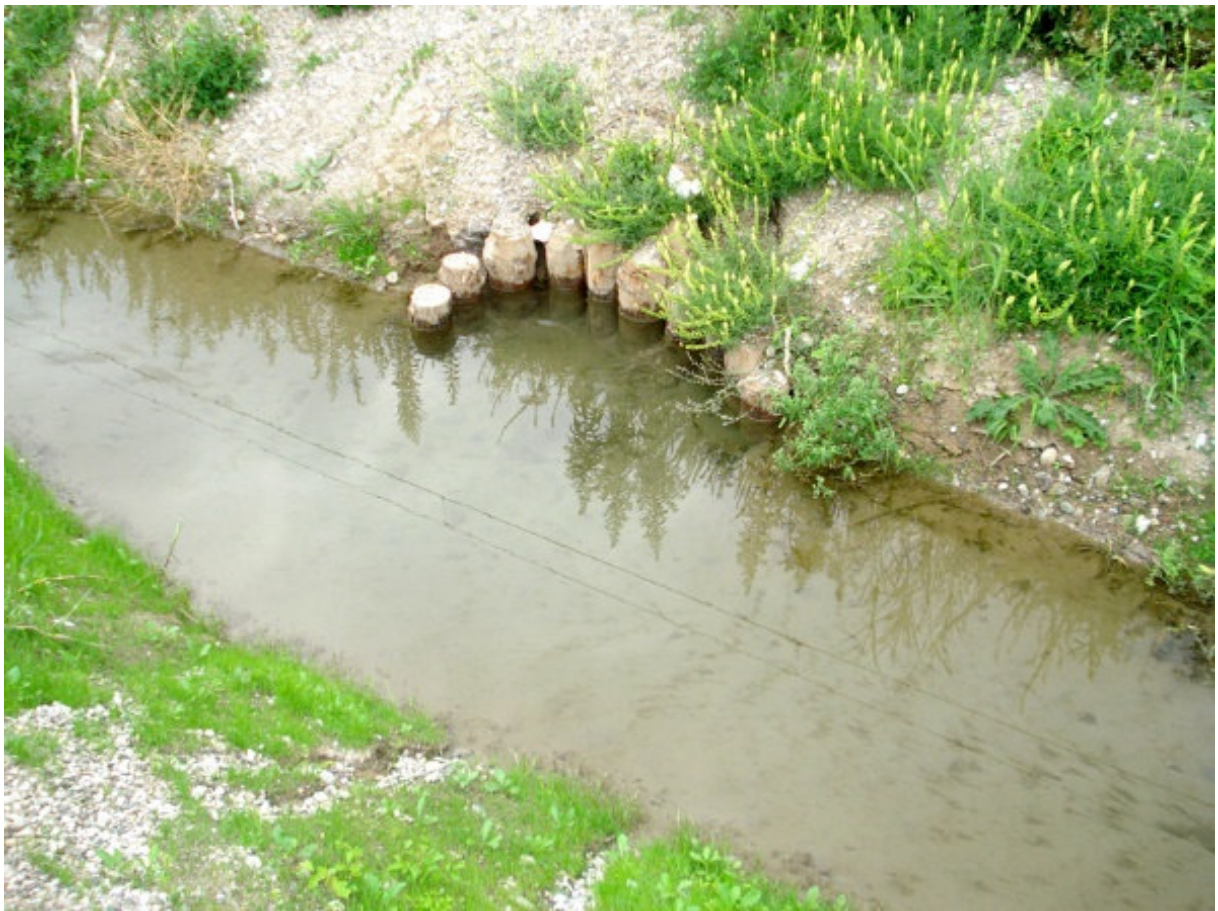
Abb. 11: Bucht aus Holzpiloten als Einstand für Fische in begradigten Bachläufen
