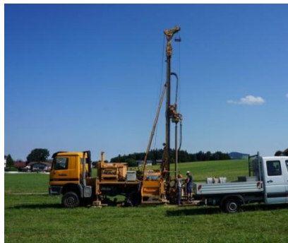
Bohrungen & Schürfungen geben Aufschluss über den Untergrund
