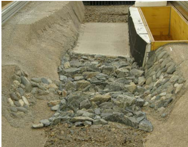
Foto: DI.Dr.techn. Johannes Nimmert/Ingenieurbüro Passer&Partner
