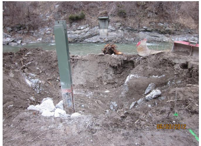
Einzig die Stütze der Messeilbahn hat sich zunächst dem Bagger-Angriff erfolgreich entgegengesetzt. Aber auch sie – so wie die Stütze am Gegenufer (Bildhintergrund) – wird im Zuge des Pegelneubaues ersetzt.
