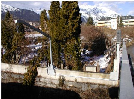
Pegel Imst/Malchbach: Der 2004 neu errichtete Pegel fiel infolge einer späteren kraftwerksbedingten Wasserausleitung in die Restwasserstrecke. Ende Jänner wurde auf Kosten des Kraftwerksbetreibers eine Ersatzmessstelle unterhalb der Wasserrückgabe errichtet, sodass endlich wieder das gesamte Wasserdargebot am Pegel ermittelt werden kann.
