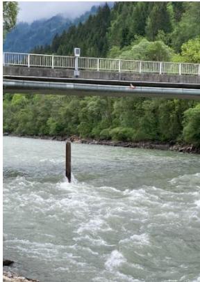
Aufnahmesäule für Geschiebefangkorb
