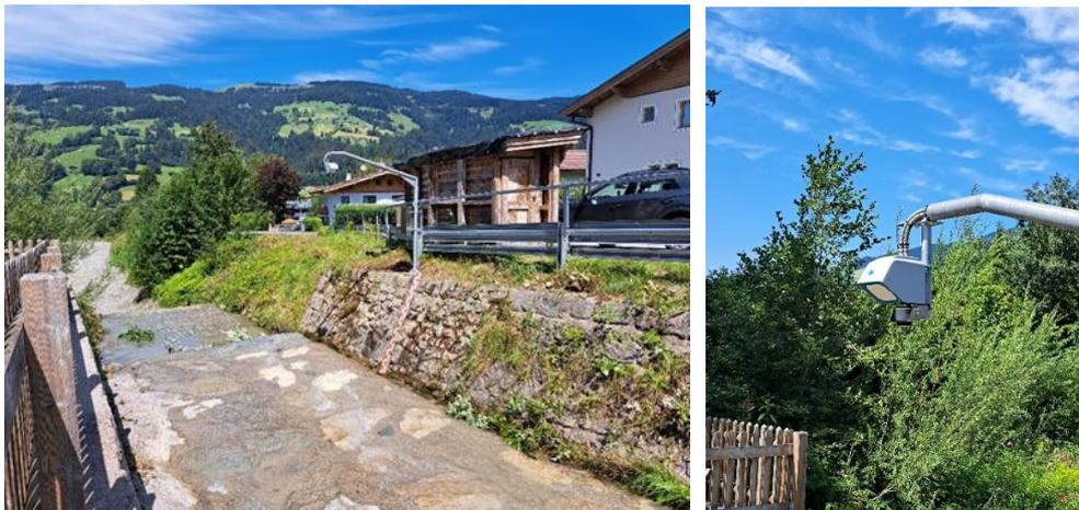
Fotos: Hydrographischer Dienst, Land Tirol; linkes Bild: Gerinneausbau, rechtes Bild: Radarmessgerät für Wasserstand und Fließgeschwindigkeit
