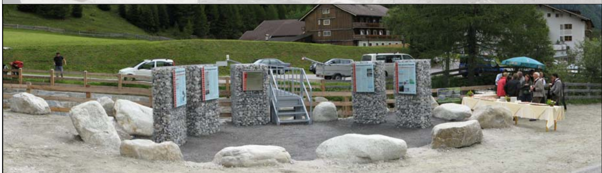
Pegelvorplatz mit Schautafeln und digitaler Leuchtanzeige am Schaltschrank
