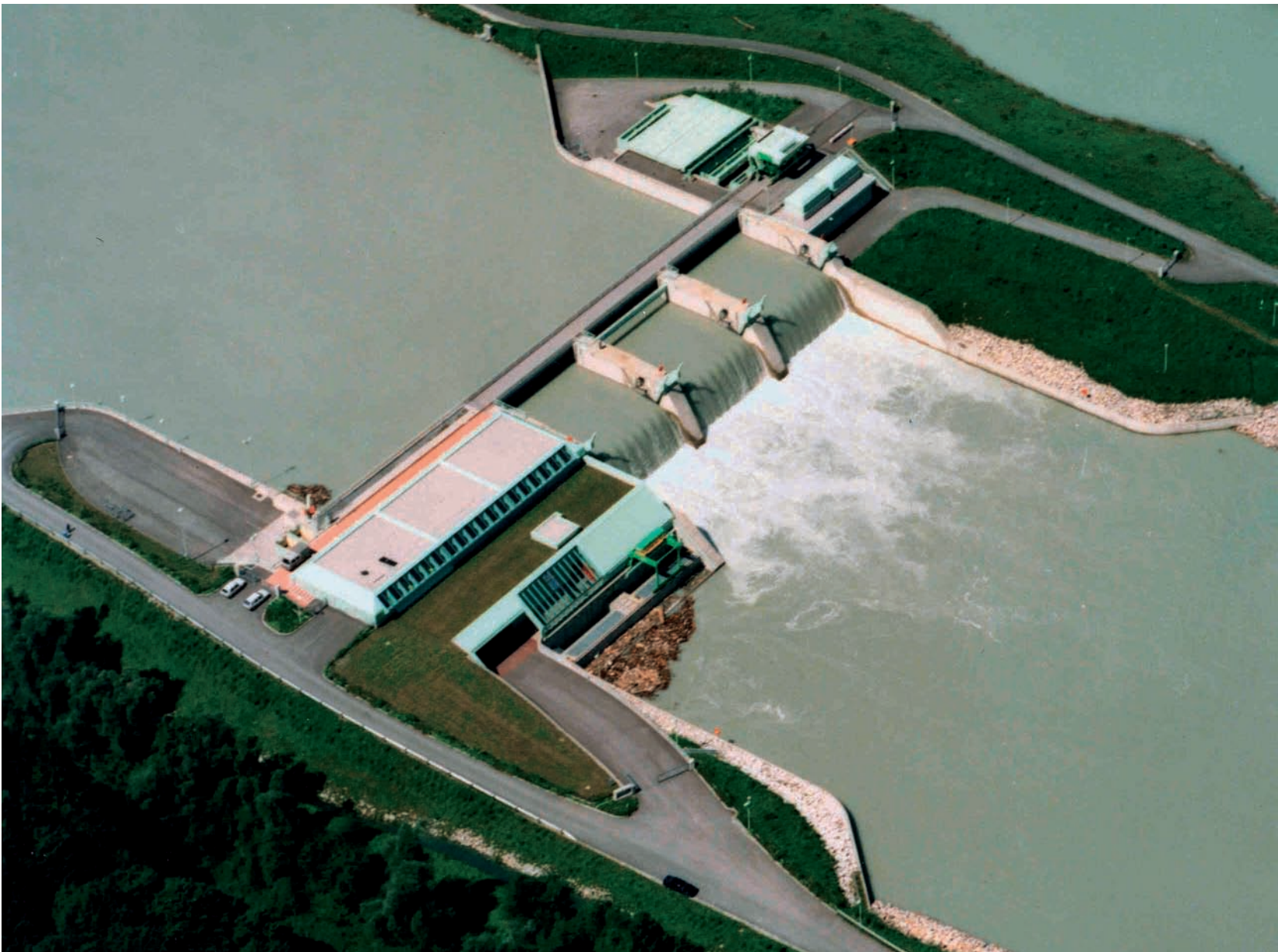
Das 1998 errichtete Inn-Kraftwerk Langkampfen der TIWAG zählt mit einer Leistung von 32.000 kW zu den bedeutendsten Laufkraftwerken am Tiroler Inn
