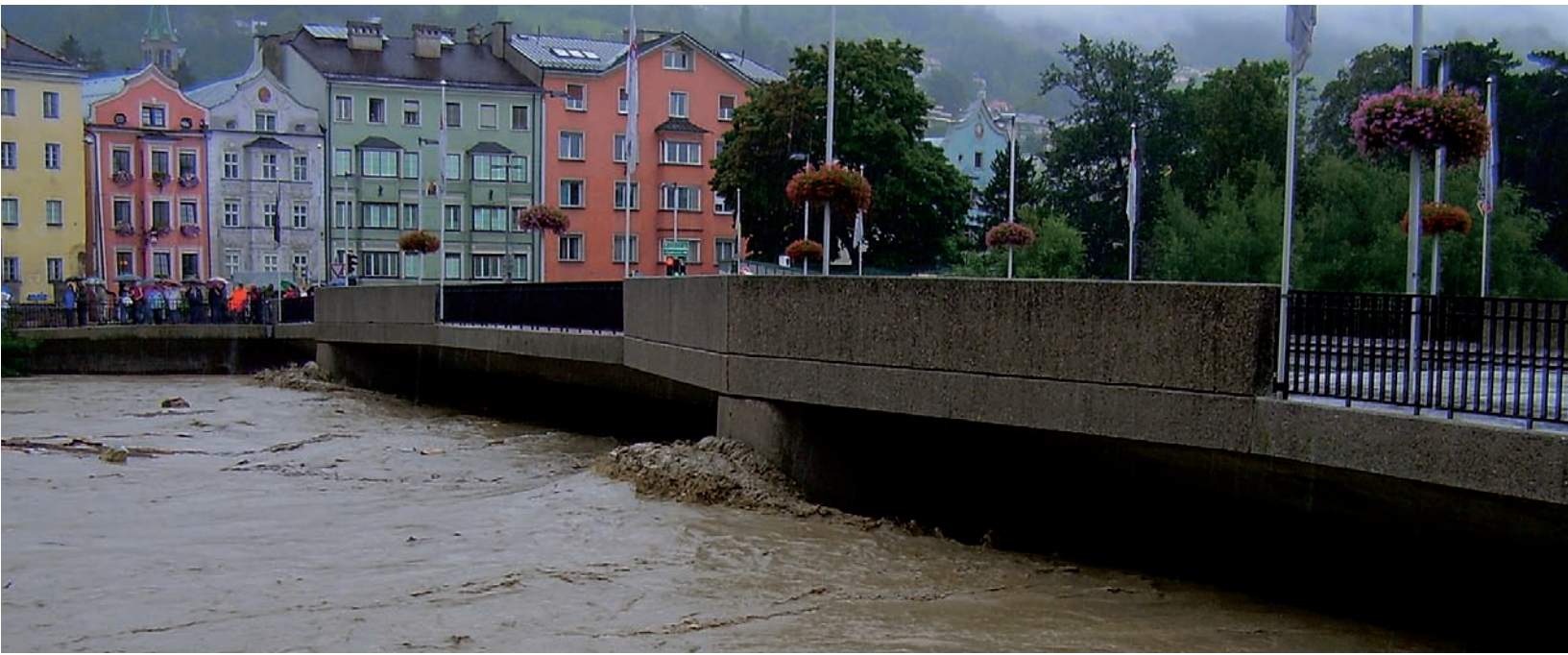
23. August 2005: Die Höttinger Innbrücke trotz dem größten jemals aufgezeichneten Hochwasser.
