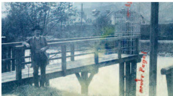
Frühe Pegelanlage an der Sill mit Limnographen um 1910
