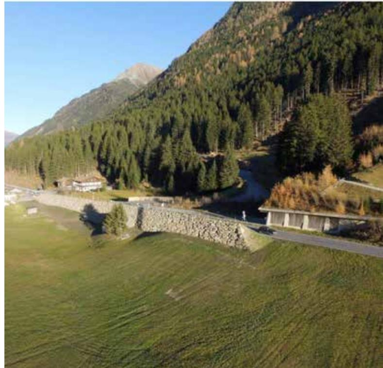
Somit konnte am nordseitigen Straßenrand der B 188 Paznauntalstraße östlich der bestehenden Schweizermaispalastgalerie ein Lawinenschutzdamm errichtet werden. Der Damm wurde als Erdwall mit einer Trockensteinschichtung an der zur Lawine zugewandten Seite angelegt und weist eine Gesamtlänge von 152 m auf.
