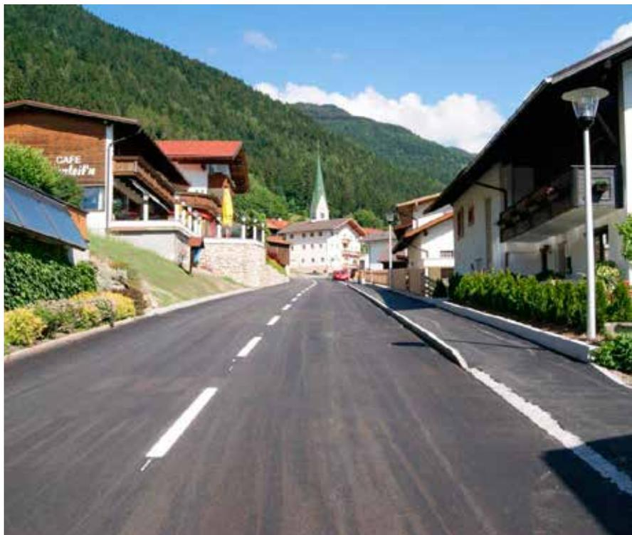
Die L 294 Brucker Straße hat eine Gesamtlänge von 2,32 km und wies vor Umsetzung der Baumaßnahmen einen zweistreifigen Straßenquerschnitt mit einer Breite von 4,30 m bis 6,00 m auf. Auf der gesamten Länge der Straße war kein Gehsteig vorhanden. 420 m befinden sich im Freiland, die restlichen 1.900 m sind Ortsgebiet.
