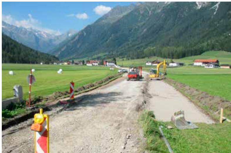
Die Sanierung der Ortsdurchfahrt Gschnitz besteht aus drei Teilen. Der letzte und dritte Teil der Sanierung erstreckt sich über 1,2 km vom Ortsanfang Gschnitz bis zum Reisbichlbach und schließt hier nahtlos an den bereits sanierten Abschnitt an.
