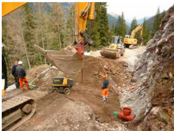
damit sinnvoll verwertet. Durch das Aufbrechen vor Ort konnte die kostspielige Anlieferung von rund 10.000 m<sup>3</sup> Frostkoffer (das entspricht rund 1.000 LKW-Fahrten) eingespart werden. Weiters wurden rund 4.000 m<sup>2</sup> bergseitige Böschung abgeräumt und gesichert bzw. die talseitige Böschung stabilisiert. Dabei wurden rund 1.000 lfm. Anker sowie über 100 m<sup>3</sup> Spritzbeton verbaut. In 240 LKW-Fuhren wurden 3.200 t Asphalt auf den Staller Sattel transportiert.
