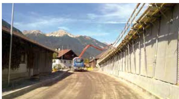
Im gesamten Baulosbereich konnte zudem entlang der bestehenden Häuser ein Gehsteig errichtet werden. Der Ortsteil Rain wurde dabei durch einen oberhalb der Stützmauer verlaufenden Gehweg fußläufig angeschlossen. Zum Schutz der Anrainer wurde die neu errichtete Stützmauer zudem mit Lärmschutzelementen ausgerüstet.
