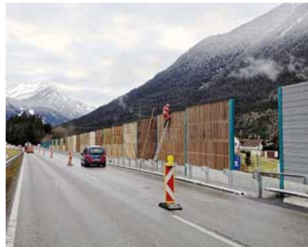
Zum Schutz und zur Entlastung der Bevölkerung gegen Immissionen aus dem Verkehrslärm wurde nunmehr im Herbst 2014 eine an die gegebenen Anforderungen angepasste, rund 550 m lange und 4 m hohe Lärmschutzwand errichtet. Die Hauptarbeiten wurden bereits im Spätherbst 2014 fertig gestellt. Die abschließende Rekultivierung im Baufeldbereich erfolgt im Frühjahr 2015.
