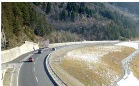
In der Neuplanung wurden die beiden Radien auf 300 m vergrößert und die max. Querneigung wurde auf 3,5 % reduziert. Bergseitig wurde mit einer Erdstützkonstruktion ein Damm zum Schutz der B 180 Reschenstraße vor Steinschlag errichtet, die Geometrie des Dammes wurde den Platzverhältnissen angepasst. Die Bewehrte-Erde-Konstruktion weist eine Länge von ca. 190 m und eine Höhe von 3,0 m auf.
