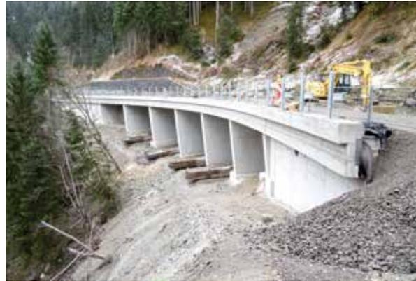
Die B 165 Gerlosstraße wird zwischen der Schönberggrabenbrücke bei km 49,868 und Martegg bei km 50,180 ausgebaut und somit an den für Landesstraßen in Tirol üblichen Ausbaugrad angepasst. Die Verbreiterung der Straße erfolgt ausschließlich talseitig und die bergseitigen bestehenden Stützmauern bleiben erhalten.
