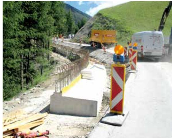
In einer Bauzeit von Ende Mai 2016 bis Oktober 2016 wurde der Bereich „Aufstieg Schmirn“ von Straßen-km 2,4 bis 3,4 der L 229 Schmirntalstraße fertig gestellt. In den vergangenen Jahren wurden bereits Teilabschnitte realisiert. Zudem wurde als vorgezogene Maßnahme die hangseitig steile und brüchige Felsböschung im Bau Feld massiv abgetragen und mit einer Felsvernetzung dauerhaft gesichert.
