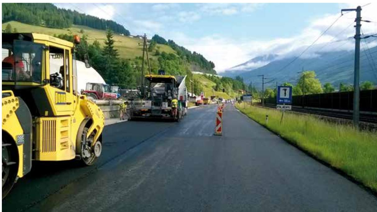
Asphaltfertiger und Walzeneinsatz zum Verdichten auf der B 182 Brennerstraße
