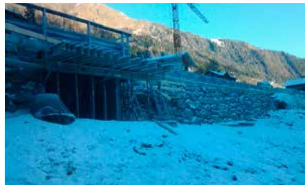
Im Herbst 2016 wurde festgestellt, dass sich auf der L 24 Virgentalstraße im Bereich von Wallhorn eine talseitige Mauer auf rund 80 m „ausbaucht“ und bereits Steine in das darunterliegende Feld fallen. Durch das „Ausbauchen“ der Mauer sind bereits massive Schäden auf der Fahrbahn aufgetreten.
