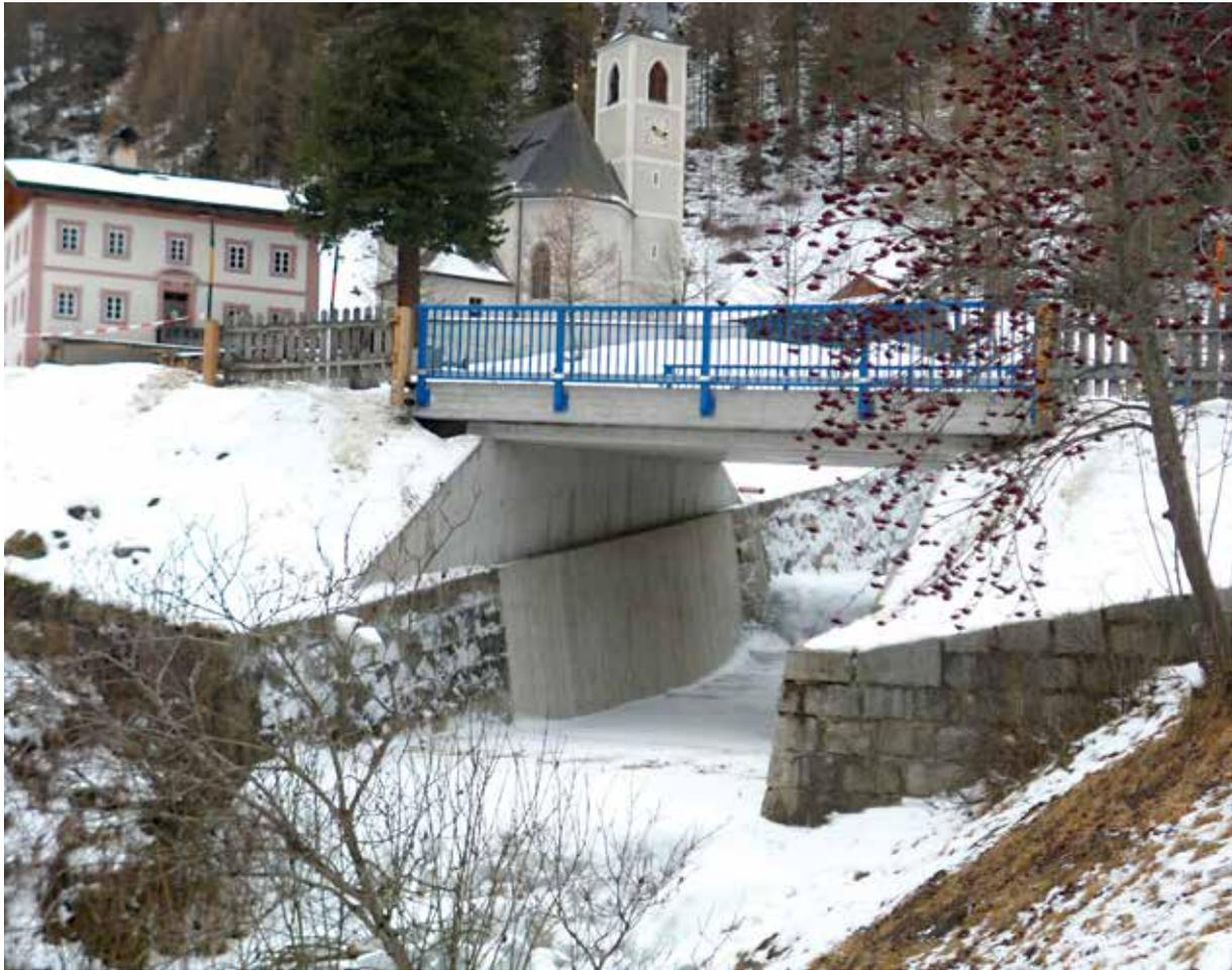
Direkt im Zentrum von Kalkstein in der Gemeinde Innervillgraten wurde das bestehende Stahlträger-Holztragwerk der Roßtalbachbrücke durch ein modernes, dem Stand der Technik entsprechendes Stahlbetonrahmentragwerk ersetzt.
