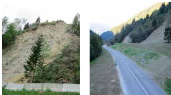
zusätzliche Sicherung der Landesstraße ein rund 90 m langer und 3 m hoher Steinschlagschutzdamm errichtet. Die verbleibende Böschungfläche wurde im oberen Bereich durch die Pflanzung eines Initialgürtels mit 400 Lärchen, 100 Ahorn, 100 Salweiden sowie 1000 Weidenstecklingen und im unteren Bereich mit Kokosmatten stabilisiert. Die restliche Böschungfläche wurde mit vor Ort gewonnenem Samen eingesät.
