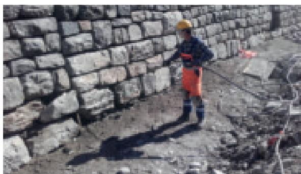
Einbringen des Fugenmörtels
