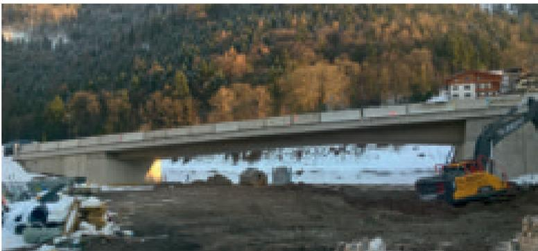
Der Neu- bzw. Erweiterungsbau der Landeslehranstalt Rotholz am Areal südlich der bestehenden L 218, Rotholzer Straße erfordert einen Brückenneubau. Unter dem neuen Tragwerk wird das bestehende Schulareal im Norden über einen Festplatz mit dem neuen Schulkomplex im Süden verbunden.
