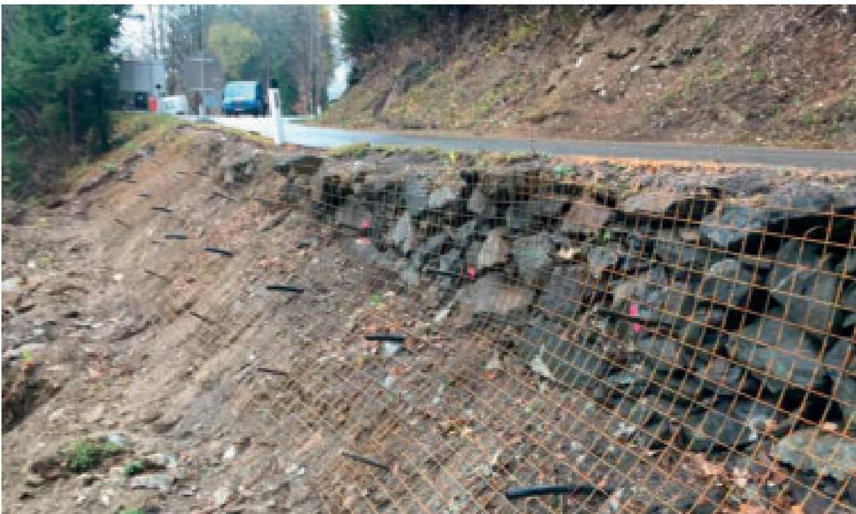
Durch starke Regenfälle Anfang August 2017 ist an der L 322 Gwablstraße an mehreren Stellen talseitig die Böschung ausgebrochen. Bergseitig sind zusätzlich überhängende Bereiche in der Böschung entstanden. Talseitig wurde zum Teil mit Spritzbeton sowie mit Hochleistungsgittern die Böschung stabilisiert. Bergseitig wurden die überhängenden Bereiche abgetragen und mit einem Hochleistungsgitter gesichert.
