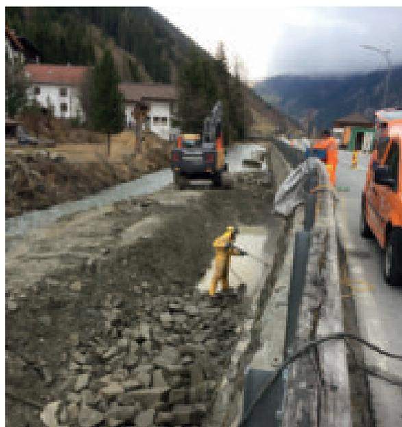
Reinigung der Uferschutzmauer durch Hochdruckwasserstrahlung
