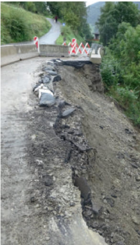
Sanierung der L 38 Ellbögener Straße bei km 16,0 durch Errichtung einer Stahlbetonwinkelstützmauer auf Pfählen
