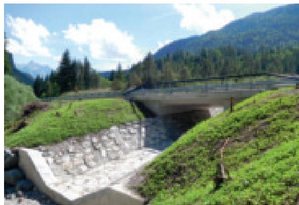
Der alte Weißlehnbachdurchlass bei km 9,76 an der B 187 Ehrwalder Straße wies nur einen Durchflussquerschnitt von 2 m<sup>2</sup> auf. Beinahe bei jedem stärkeren Regenereignis vermutete der viel zu gering dimensionierte Durchlass und die B 187 Ehrwalder Straße wurde überflutet und beschädigt.
