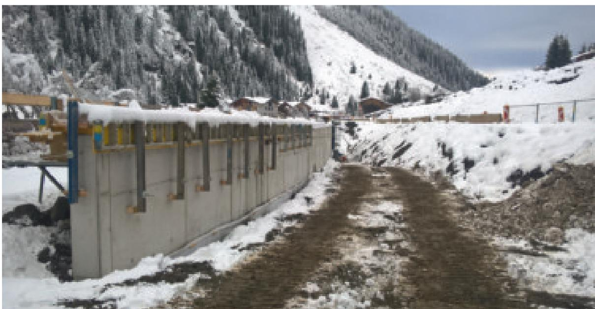
Südlich des Ortsteiles Weixmannstall der Gemeinde St. Leonhard werden eine 162 m lange Lawingalerie, ein 210 m langer Lawinendamm und mehrere Mauern errichtet, die Landesstraße auf eine Länge von rund 300 m verlegt und gewässerökologische Maßnahmen entlang der Pitze durchgeführt. Das Bauvorhaben dient zum Schutz gegen die Schützeslawine und die Hirschpillbachlawine von der gegenüberliegenden, orographisch linken Talseite.
