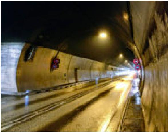
So wurde der Pontlatztunnel an der B 180 Reschenstraße mit einer LED-Leiteinrichtung am erhöhten Seitenstreifen ausgestattet, um die Verkehrsführung zu verbessern. Die Energieversorgung der LED-Module erfolgt hier durch eine Photovoltaikanlage, da eine herkömmliche Stromversorgung nicht wirtschaftlich zu realisieren war.
