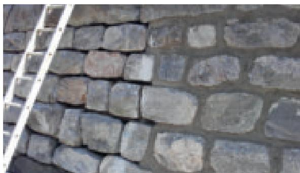
Uferschutzmauer ohne und mit Fugenmörtel
