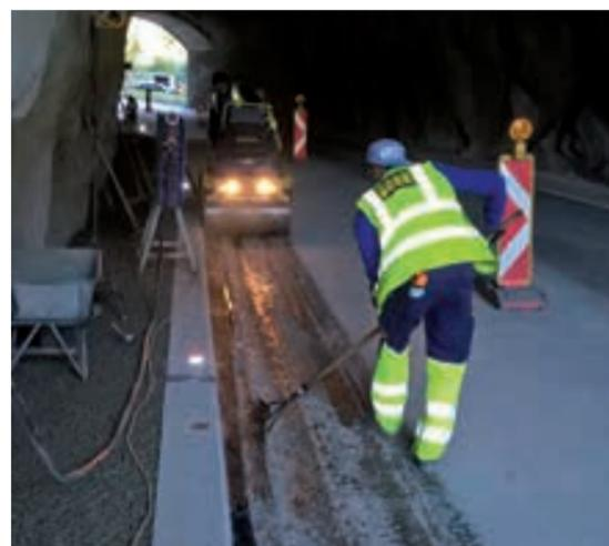
Der Gehördetunnel mit einer Länge von 70 m befindet sich auf der B 186 Ötztalstraße bei km 33,40 im Ortsteil Gehörde der Gemeinde Sölden. Zur Erhöhung der Sicherheit wurde der bestehende Tunnelquerschnitt nachprofiliert. Somit kann in Zukunft ein durchgängiges Lichtraumprofil von 6,50 m Breite und 4,50 m Höhe gewährleistet werden. Im Zuge der Bauarbeiten wurden auch die erhöhten Seitenstreifen samt LED-Leiteinrichtung erneuert.
