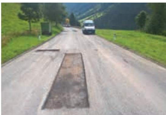
Bei dieser Belagssanierung wurde der gesamte Asphaltdeckbelag abgefräst. Anschließend daran wurden die geschädigten Bereiche der Asphalttragschicht abgefräst und erneuert (Fenstersanierung). Auf diese instand gesetzte Tragschicht wurde auf die gesamte Fläche der Straße eine 3 cm starke Asphaltdeckschicht der Sorte AC11deck70/100,A1,G1 aufgebracht.
