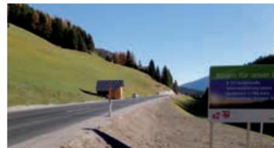
Aufgrund massiver Setzungen auf der talseitigen Fahrspur wurde die B 111 Gailtalstraße in diesem Bereich bergwärts verlegt und auf 6,0 m verbreitert. Im gesamten Abschnitt wird der Straßenunterbau erneuert und asphaltiert sowie die Entwässerung mit Drainagen dem Stand der Technik entsprechend angepasst. Im September 2018 wurde mit dem Ausbau begonnen, welcher im Frühjahr 2019 fertiggestellt wird.
