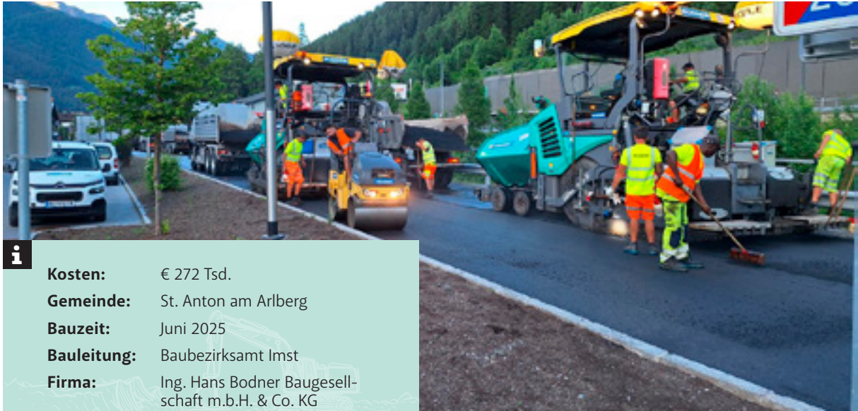
Einbau der Asphaltdeckschicht
