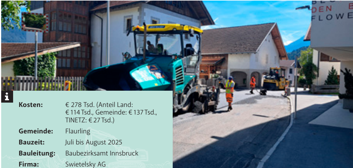
Einbau der Deckschicht
