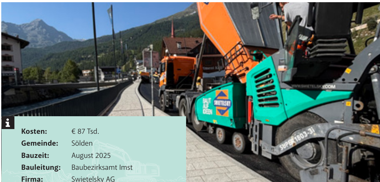
Anliefern des Asphaltmischgutes an den Asphaltfertiger
