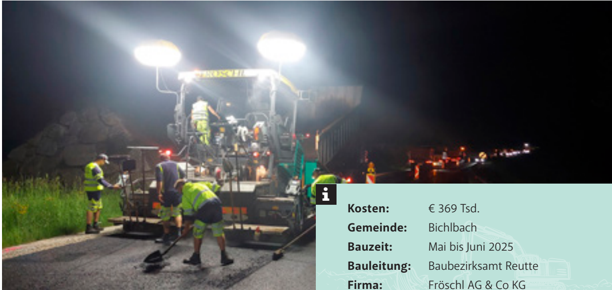
Einbau der Tragschicht in Nachtarbeit
