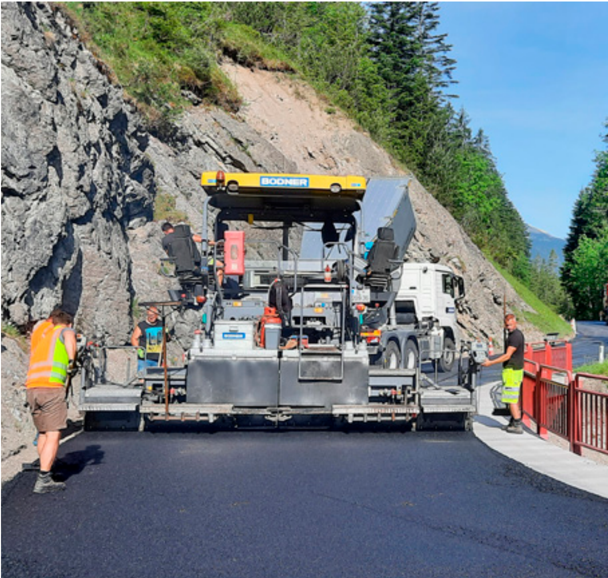
Asphaltierungsarbeiten auf der L 21 Berwang-Namloser Straße
