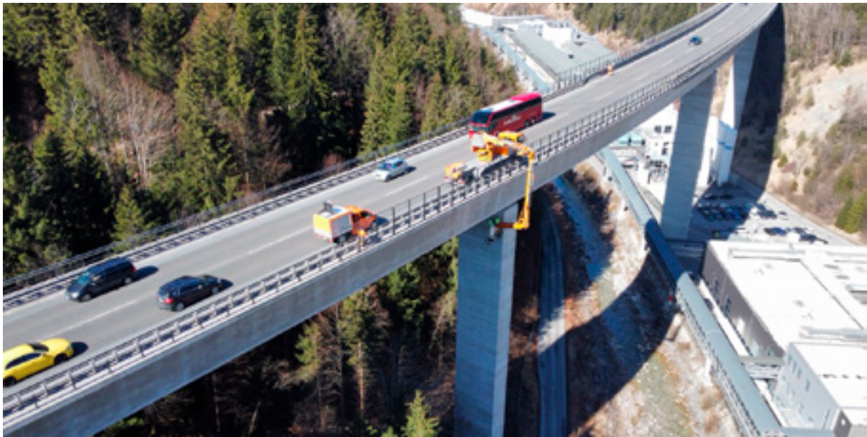
B 179 Planseewerkbrücke – Pfeilerbefahrung
