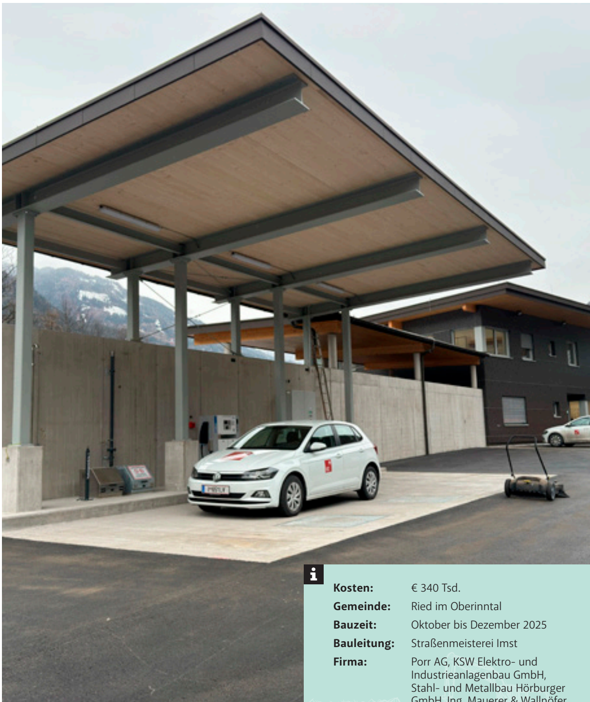
Neue Betriebstankstelle der Straßenmeisterei Ried im Oberinntal
