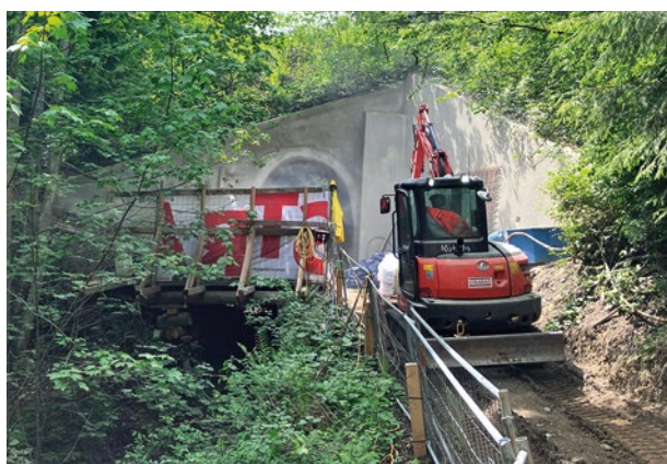
Abb. 3-13: Stubaitalbahn bei Bahnkilometer 8,834 mit Spritzbetonschale. Quelle: IVB/Thöni
