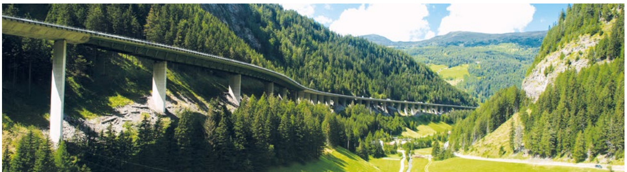
Abb. 1-17: Luegbrücke der A13 Brennerautobahn. Quelle: ASFiNAG
