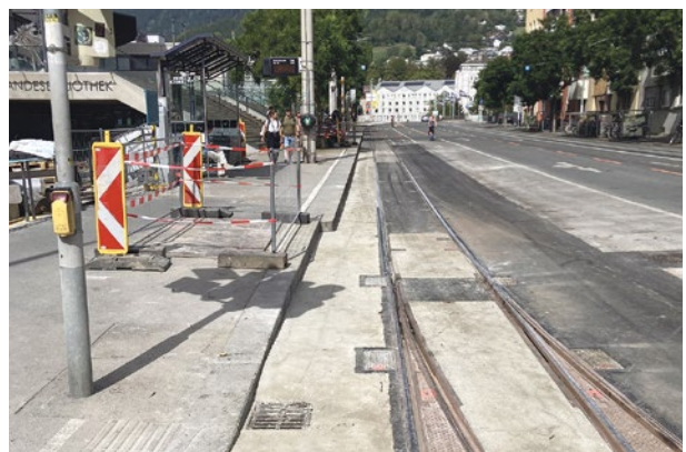
Abb. 3-10 + 3-11: Provisorisches Baugleis (oben) und neue Weiche (unten) an der Baustelle Klinikkreuzung. Quelle: IVB/Pansi
