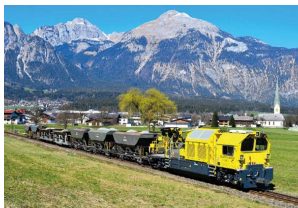
Abb. 3-15: Oberbauwagen (OBW). Quelle: Zillertaler Verkehrsbetriebe (ZVB)
