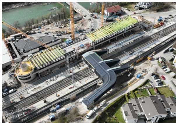
Abb. 3-5: Luftbild des Umbaus Bahnhof Fritzens-Wattens. Quelle: AEP
