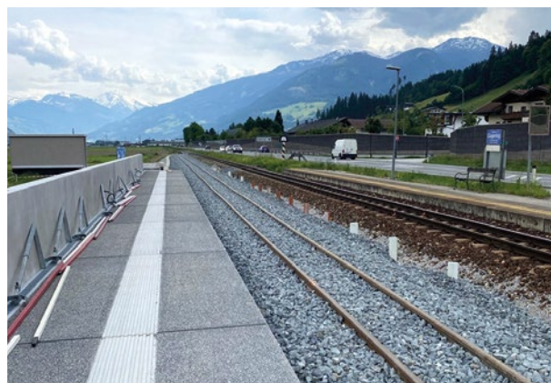
Abb. 3-14: In Bau befindliches zweites Gleis, Haltestelle Gagering. Quelle: Zillertaler Verkehrsbetriebe (ZVB)
