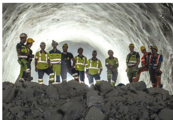
Abb. 3-6: Geglückter Durchschlag des östlichen Haupttunnels im Baulos H53 Pfons-Brenner im Gemeindegebiet von Steinach.
