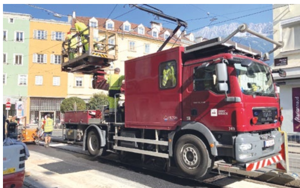
Abb. 3-13: Oberleitungsarbeiten Baustelle Burggraben. Quelle: IVB/Pansi
