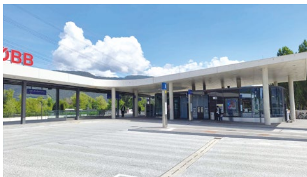
Abb. 3-8: Bahnhof Telfs-Pfaffenhofen. Quelle: Land Tirol/Kolb
