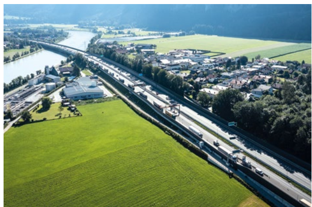
Abb. 1-7: Luftaufnahme der Dosierung bei Kufstein Nord. Quelle: Land Tirol/Simon Rainer
