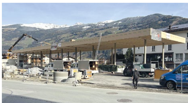
Abb. 3-16: Überdachung Bahnhof Zell am Ziller.
