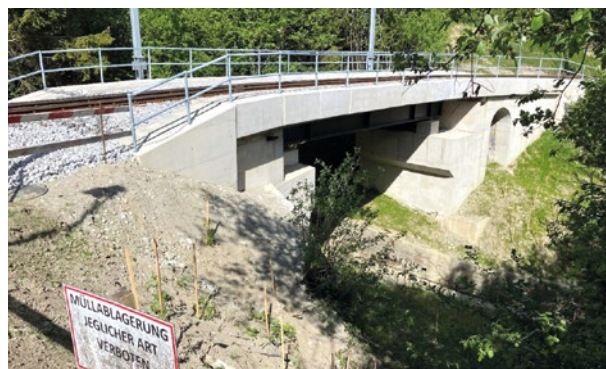
Abb. 3-15: Stubaitalbahn Riedbachbrücke. Quelle: IVB/Thöni
