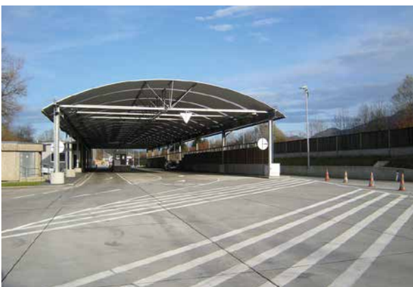
Abb. 1-18: Kontrollstelle Kundl an der A12 Inntalautobahn
