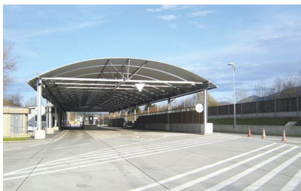
Abb. 1-11: Kontrollstelle Kundl an der A12 Inntalautobahn
