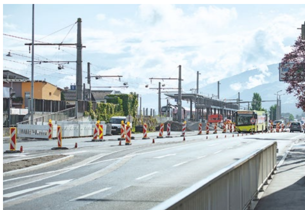
Abb. 3-10: Baustelle der Linie 5 in der Haller Straße nahe Bahnhof Rum
