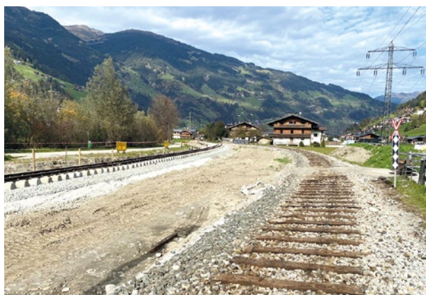
Abb. 3-13 + 3-14: Gleisarbeiten neue Trasse
