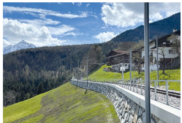
Abb. 3-12: Stubaitalbahn bei Bahnhof Kreith, generalsanierte Stahlbetonmauer
