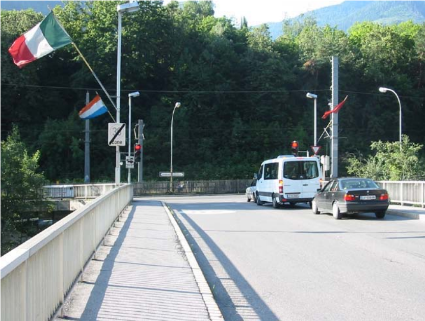
Perjener Innbrücke nördlich VLSA, Blickrichtung Süden
