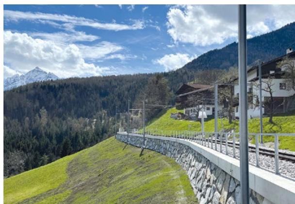
Abb. 3-12: Stubaitalbahn bei Bahnhof Kreith, generalsanierte Stahlbetonmauer
